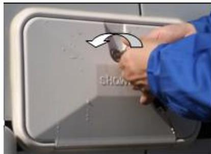
2、打开红色盖帽，插入配套接头软管（插入配套软管接头后黄色分阀才可以旋转）将黄色分阀旋转至与管路水平方向。
